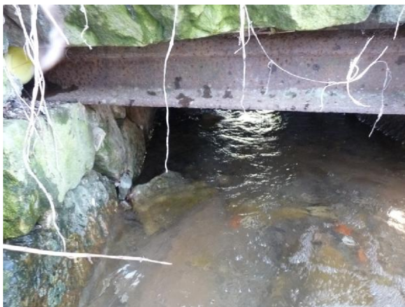
Obr.4 - Pohled na most – kamenné opory, spodní stavba
