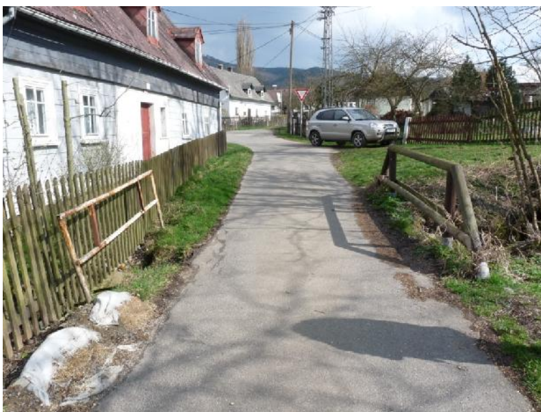
Obr.2 - Pohled na most směrem objekt .p.127 (vlevo objekt ev. ..55)
