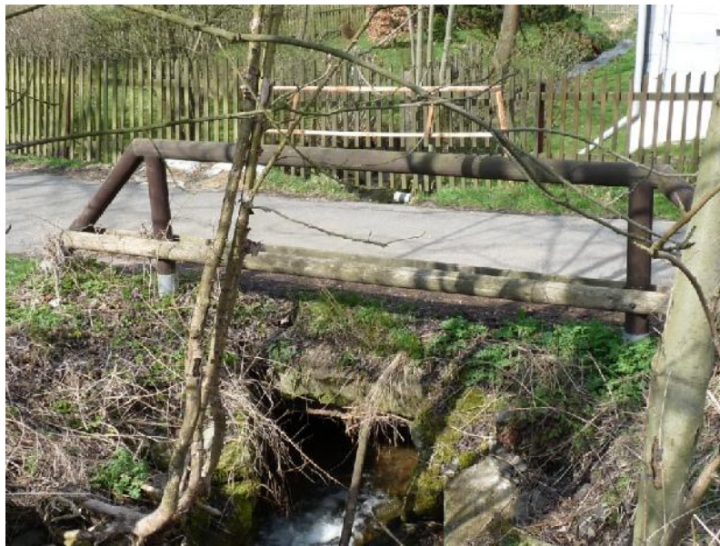
Obr.3 - Pohled na most z nátokové strany
